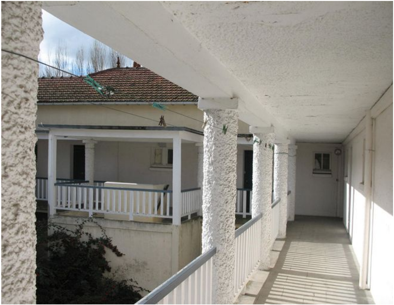
Bâtiment 520 : Premier étage de la coursive.
