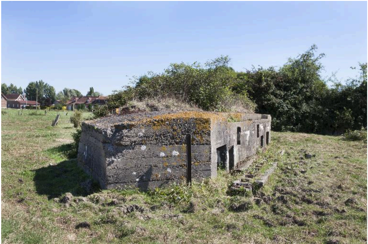
Vue générale vers le nord-est
