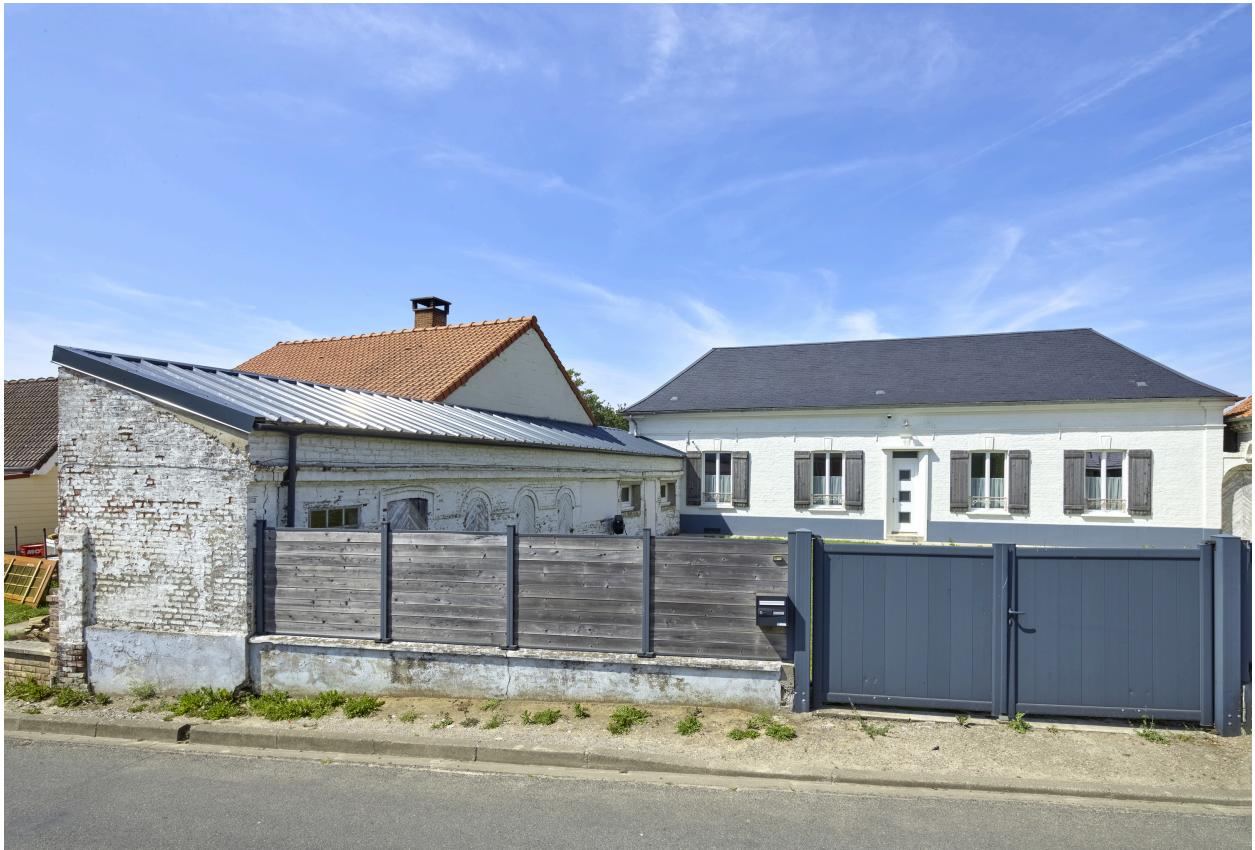
Vue du bâtiment agricole, depuis le sud.
