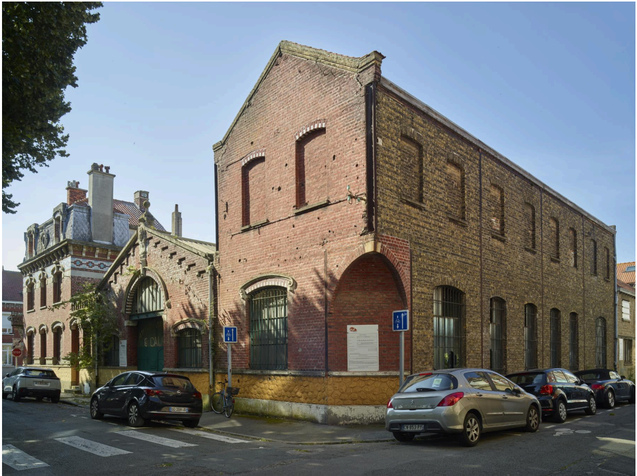
Vue générale vers le sud de l'angle de la place de l'Europe avec la rue François-Tixier (à droite).
