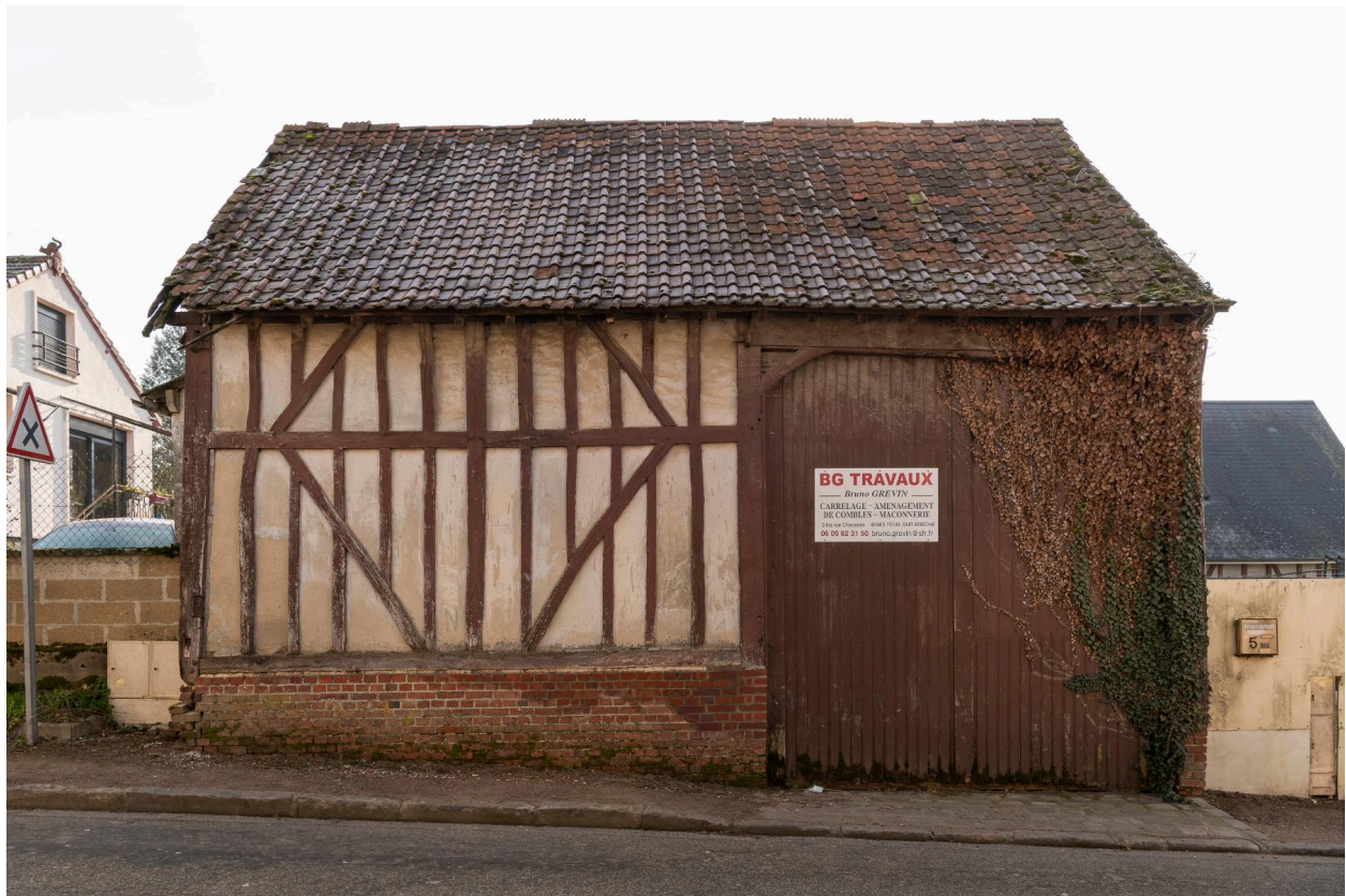
Grange sur rue, n°5 bis rue de la Chaussée, vue depuis le nord-ouest.
