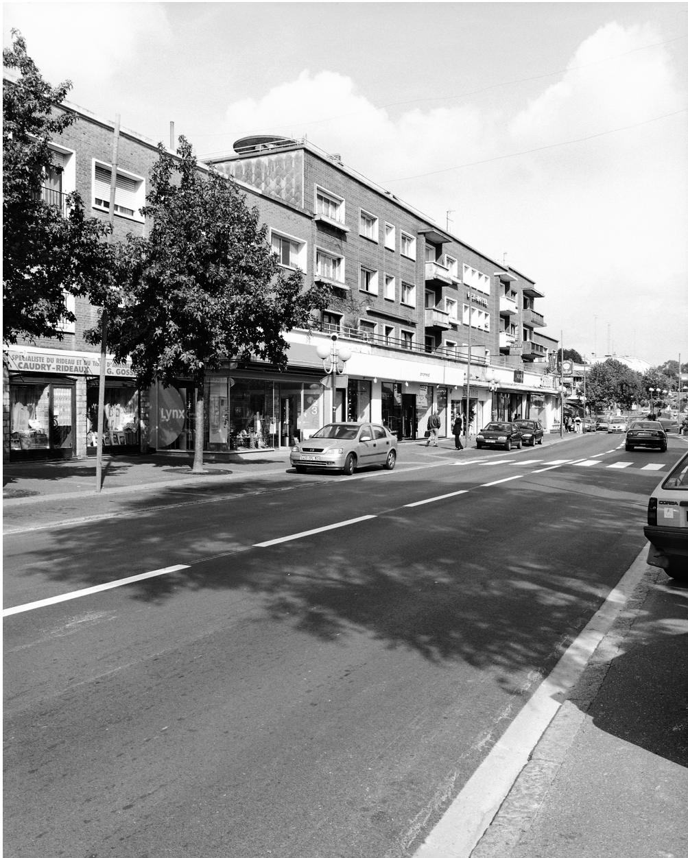
Vue générale de l'îlot I.
