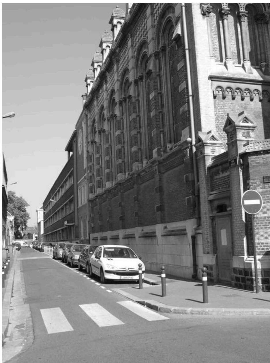
Vue des façades rue Vivien.
