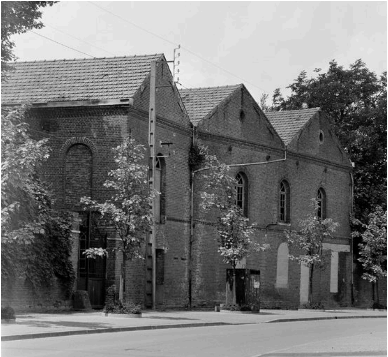
Atelier de fabrication : façade antérieure.
