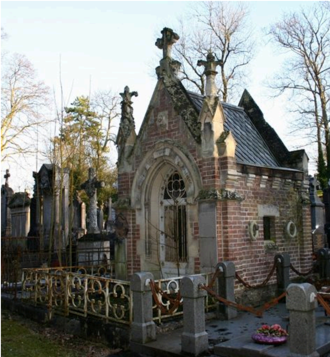
Vue générale, depuis le côté.
