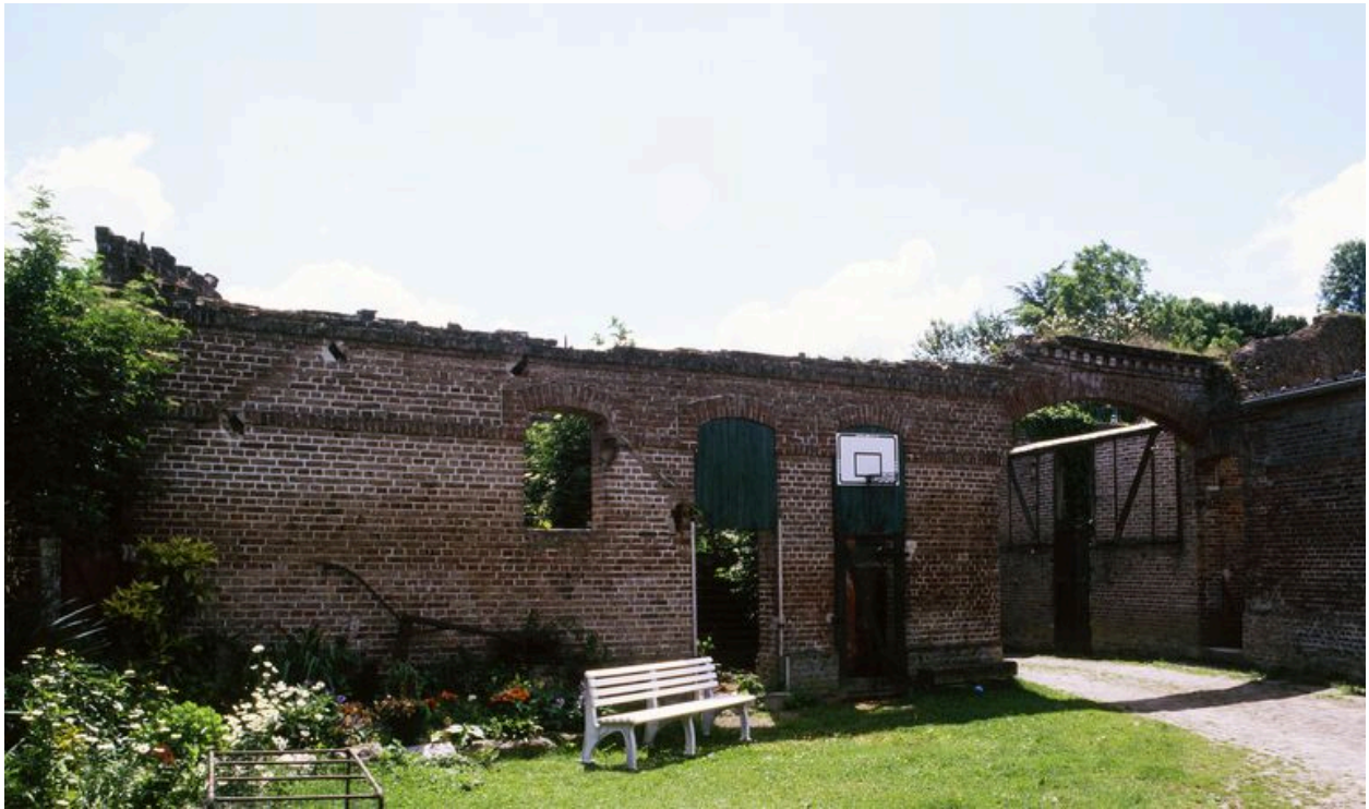
Grange et passage charretier.
