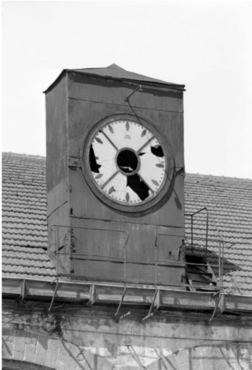
Entrepôts de réparation des locomotives : détail de l'horloge.
