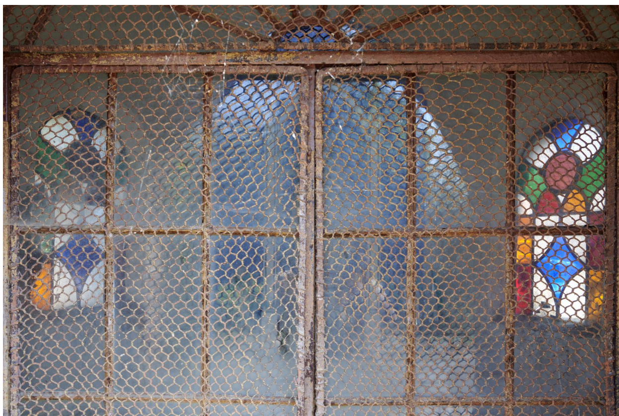
Détail de la porte grillagée et des vitraux en arrière-plan.
