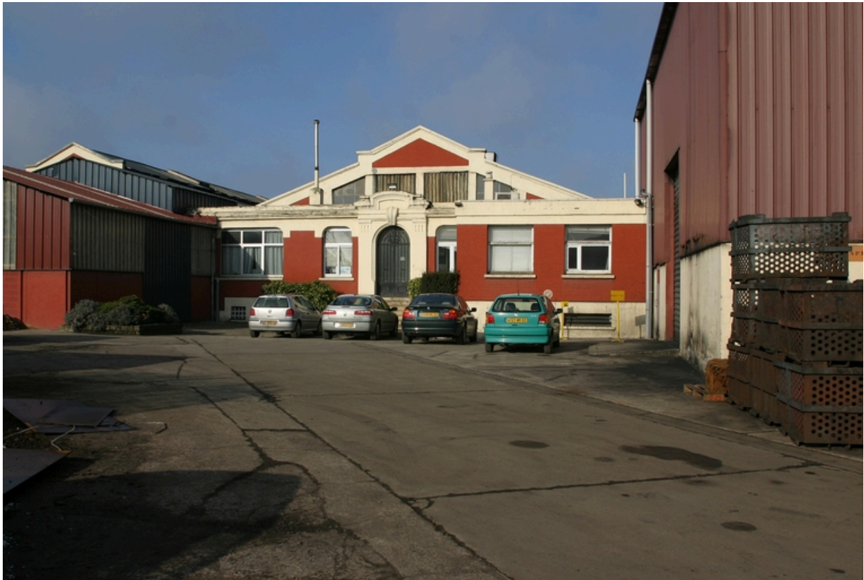
Façade antérieure des ateliers : les bureaux.
