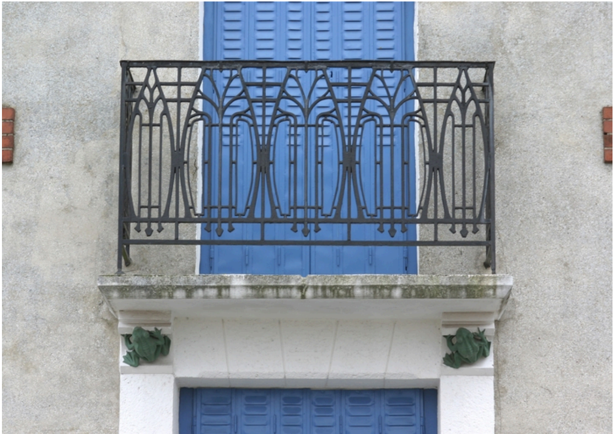
Vue de détail sur un balcon en ferronnerie.
