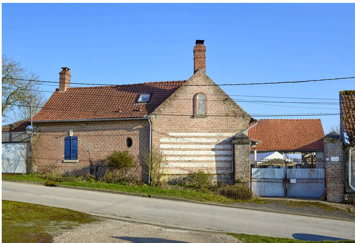
Ferme Saint-Jean, 4 rue de la Cavée.
