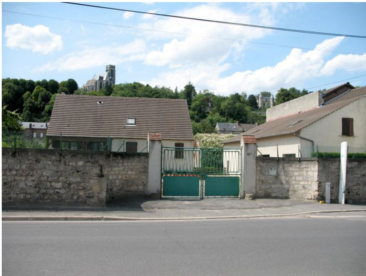
Entrée de l'ancienne usine à gaz
