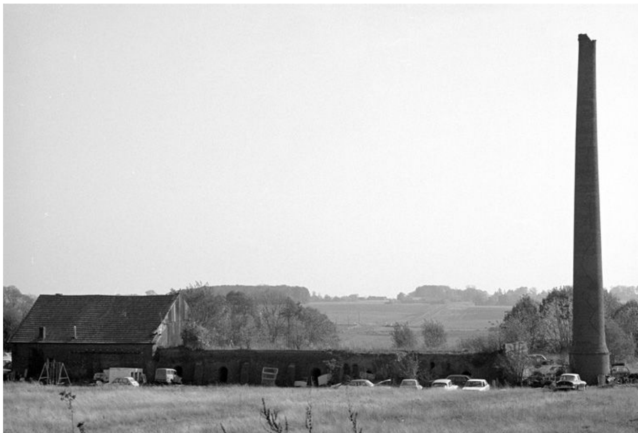
Cheminée d'usine, vue générale.
