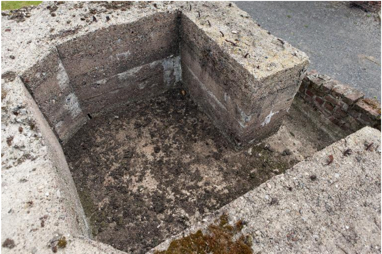
Vue en plongée sur le poste d'observation
