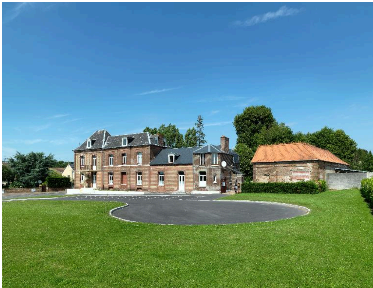
Ancien logement patronal Caqueret.
