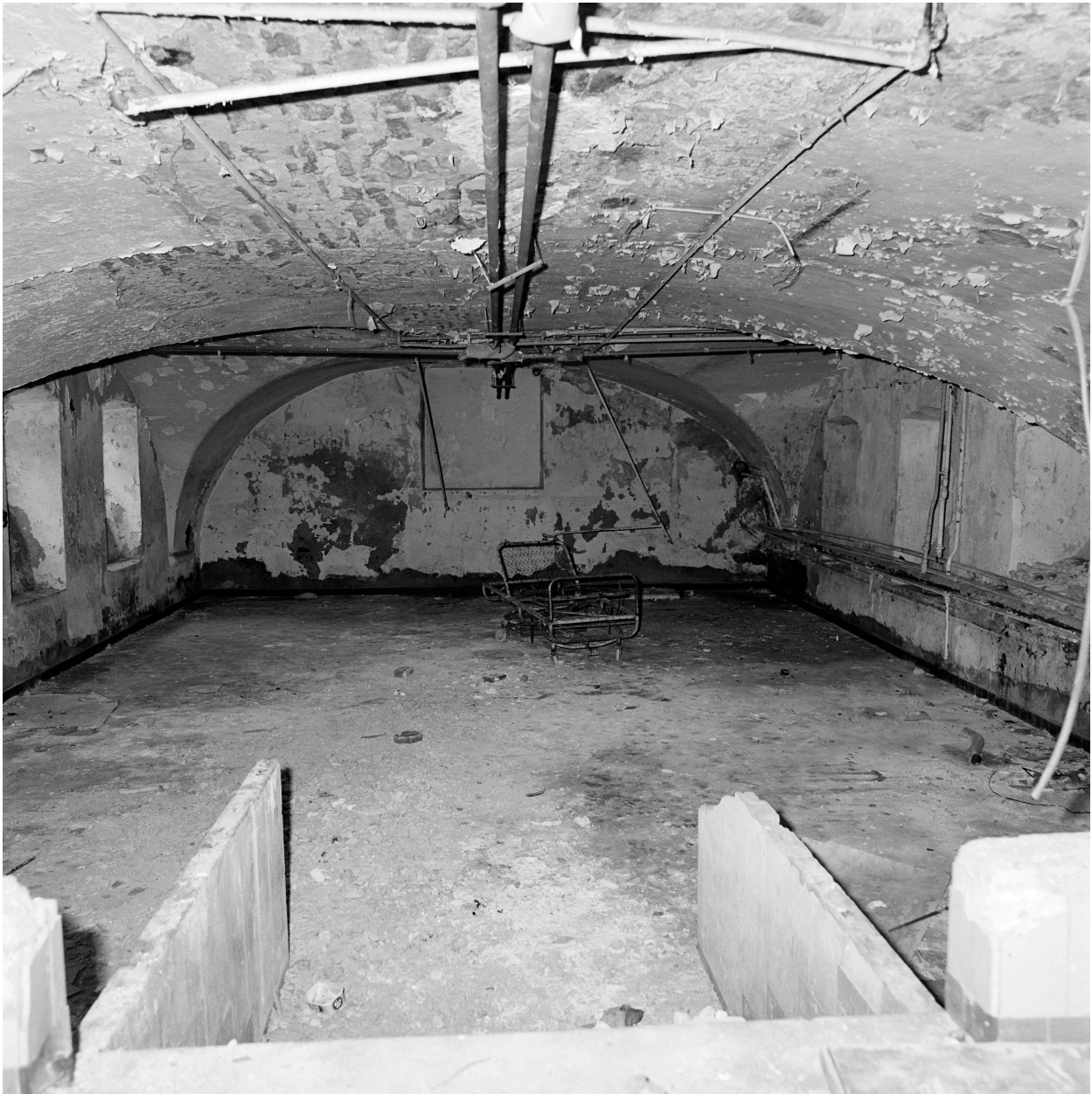
Bâtiment D, sous-sol, voûtement, vue de l'escalier.
