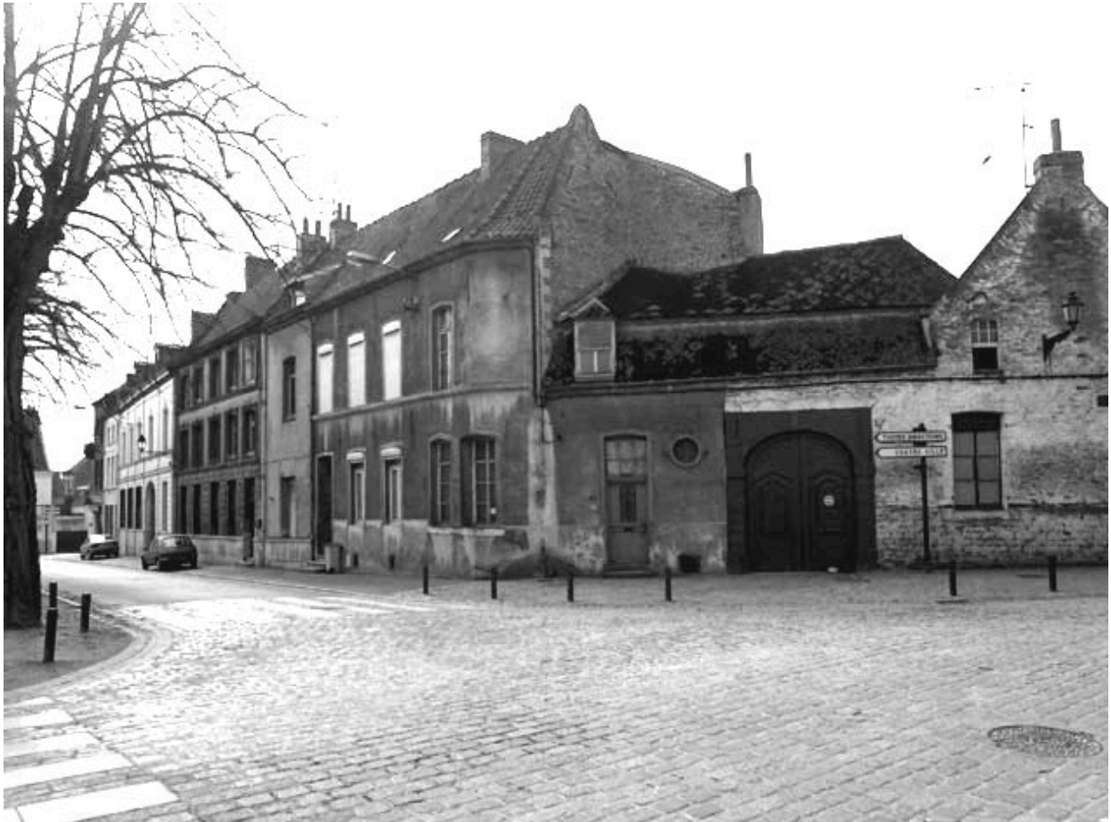
Côté sud-ouest de la place : vue générale.
