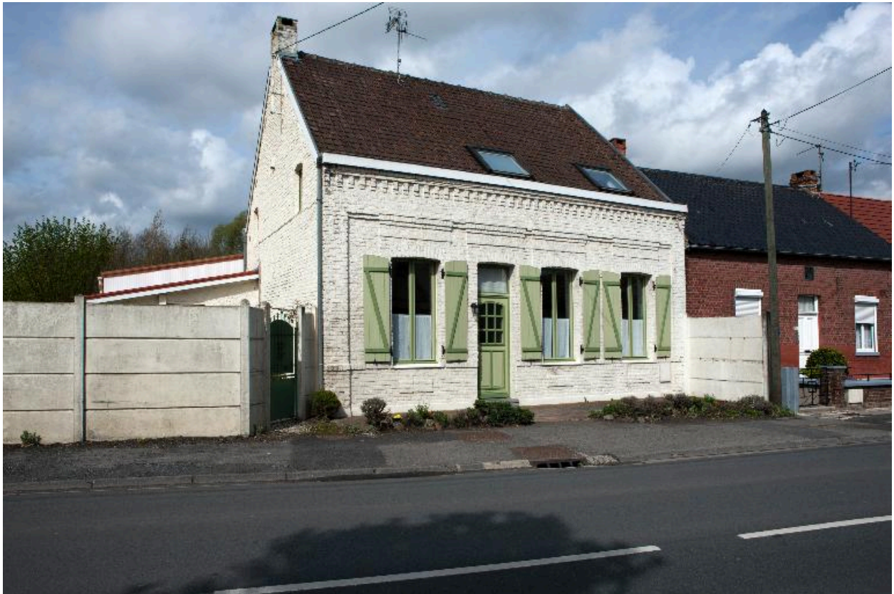
Vue générale de la maison 70 rue Jean-Baptiste-Lebas.
