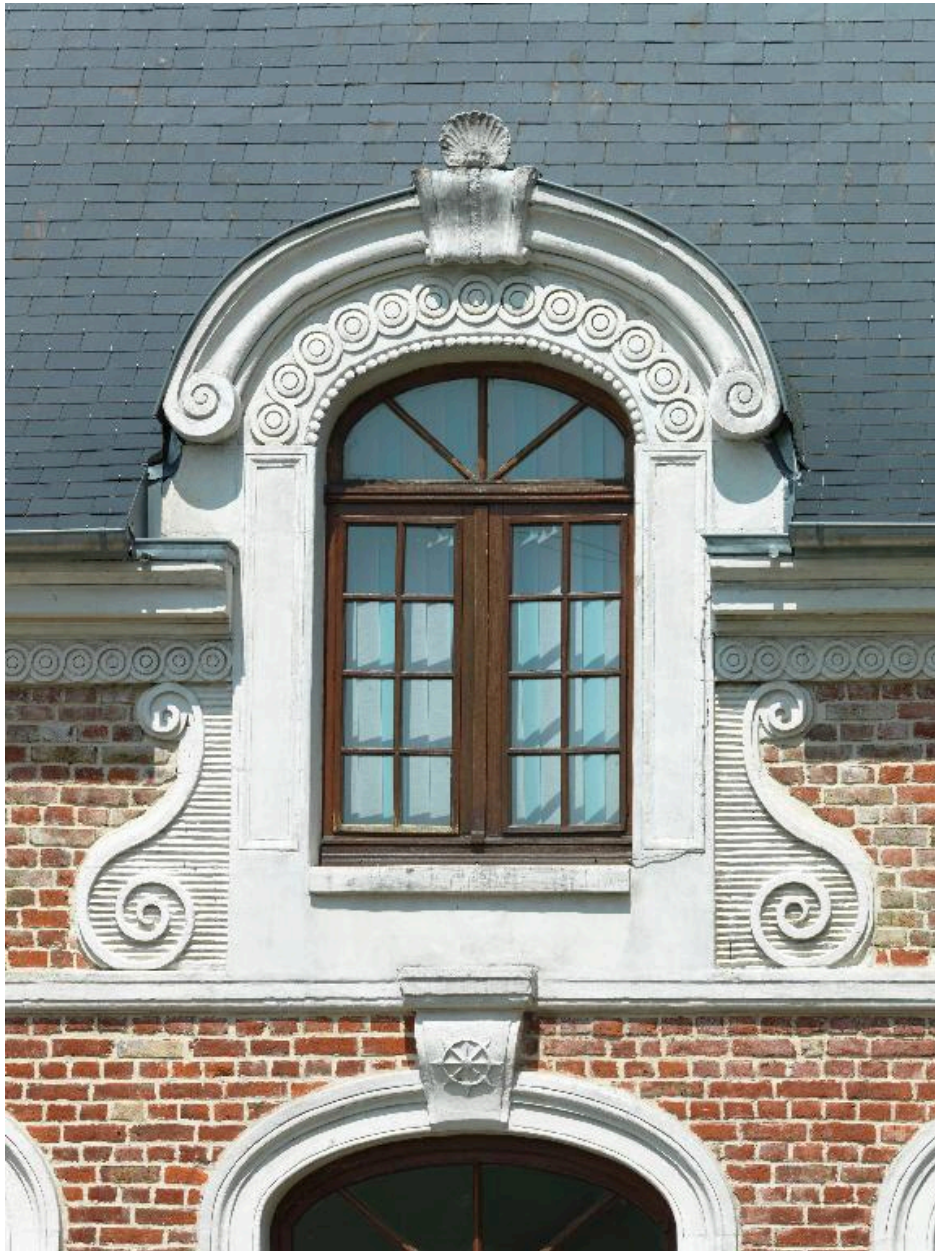
Détail de la lucarne de toit.
