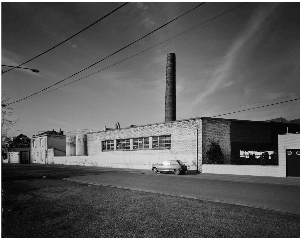
Atelier de fabrication. Vue prise vers le nord-ouest.
