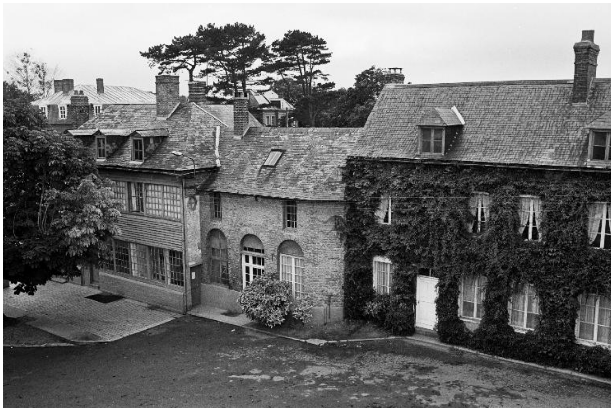
Conciergerie, bureau et vestiaires, flanc est, en 1990.
