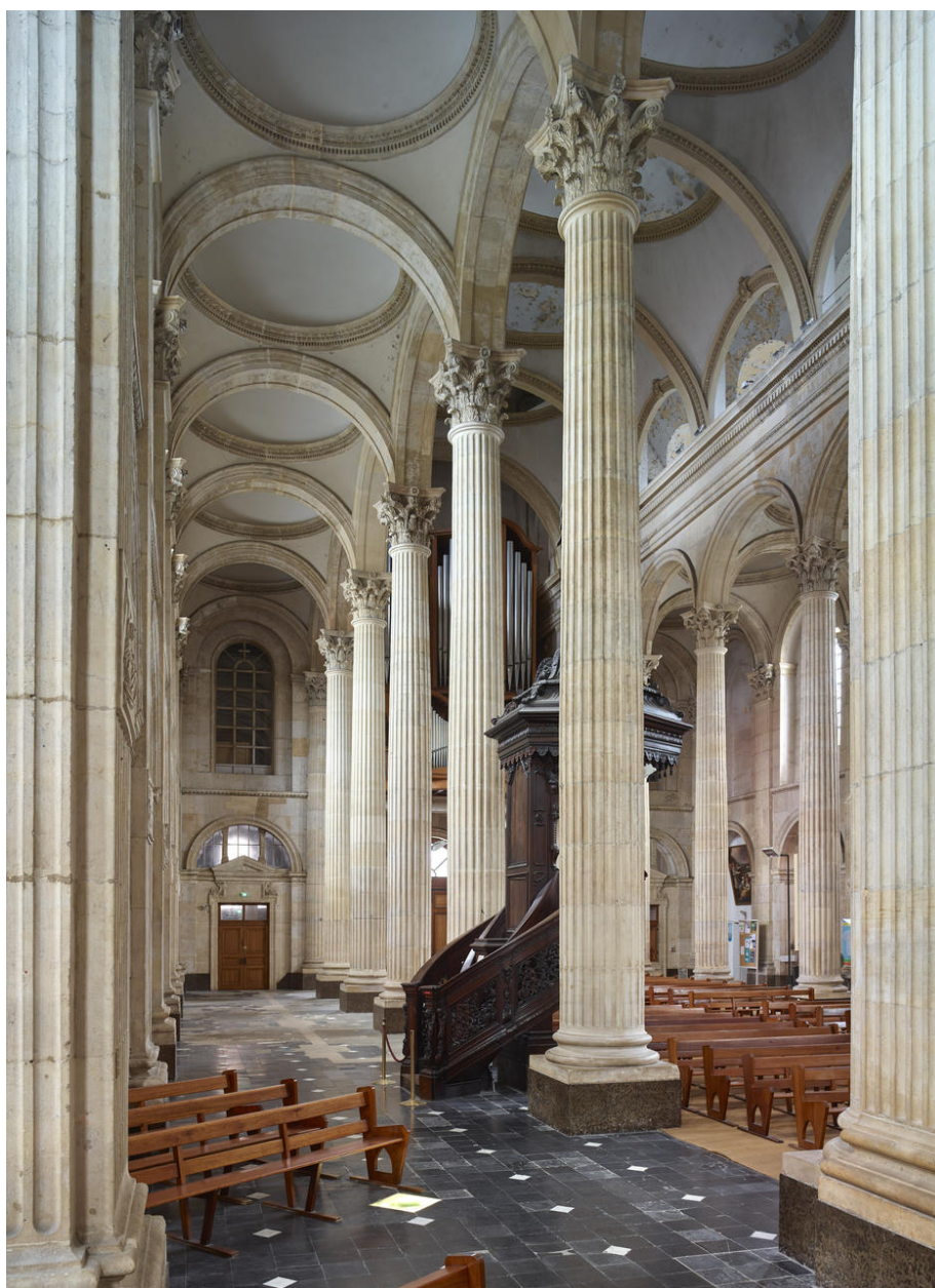
Vue du premier collatéral sud vers le narthex.
