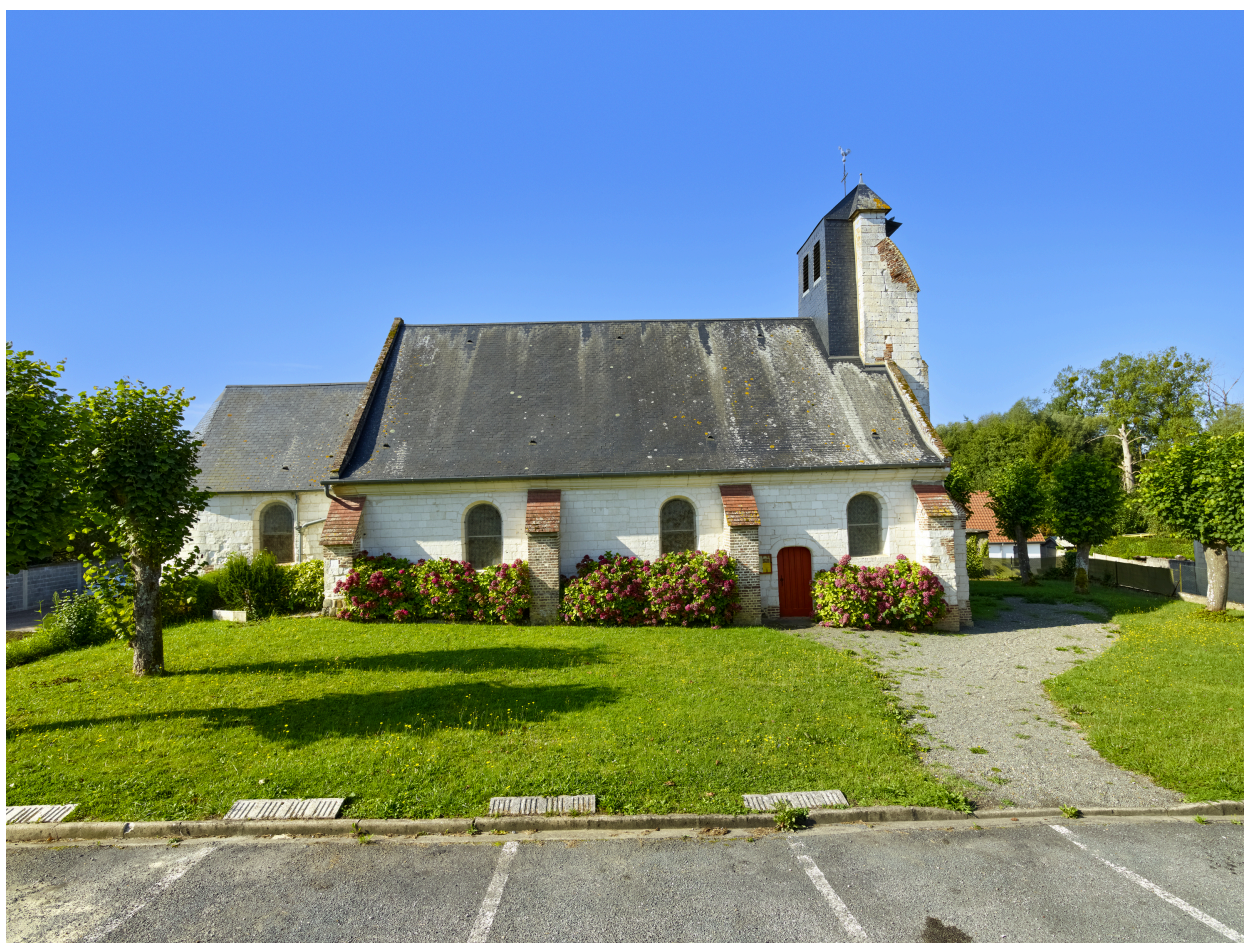
Vue de l'élévation nord.
