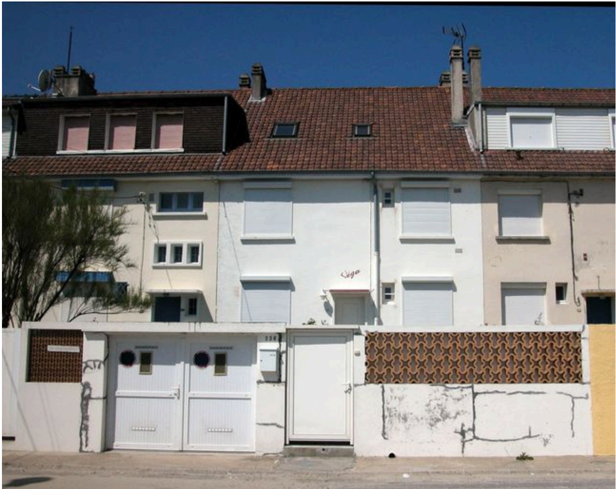
236 boulevard maritime sud (Véga), façade d'entrée.
