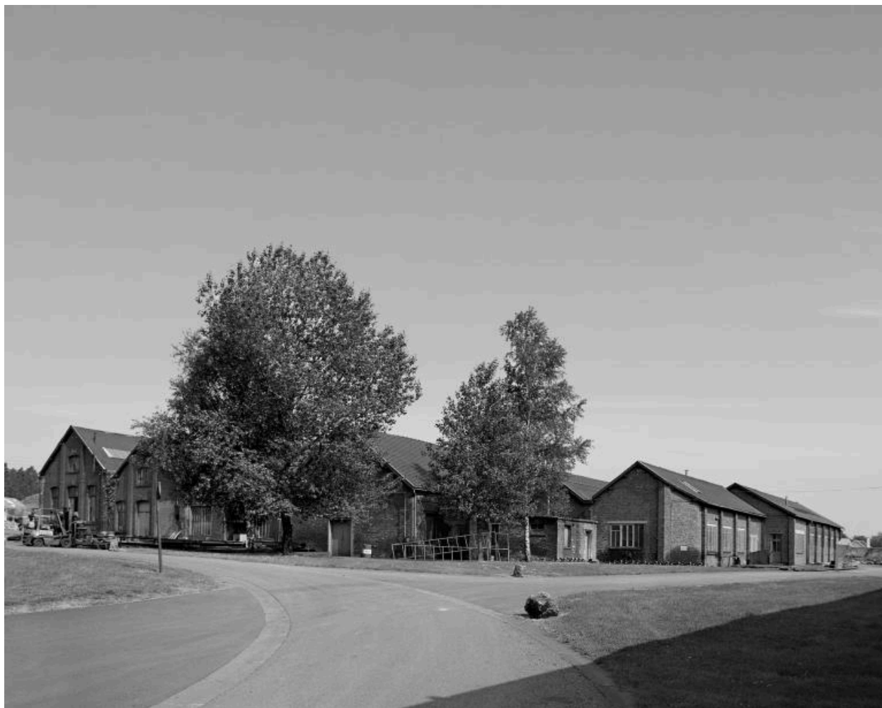
Vue extérieure des bâtiments industriels.
