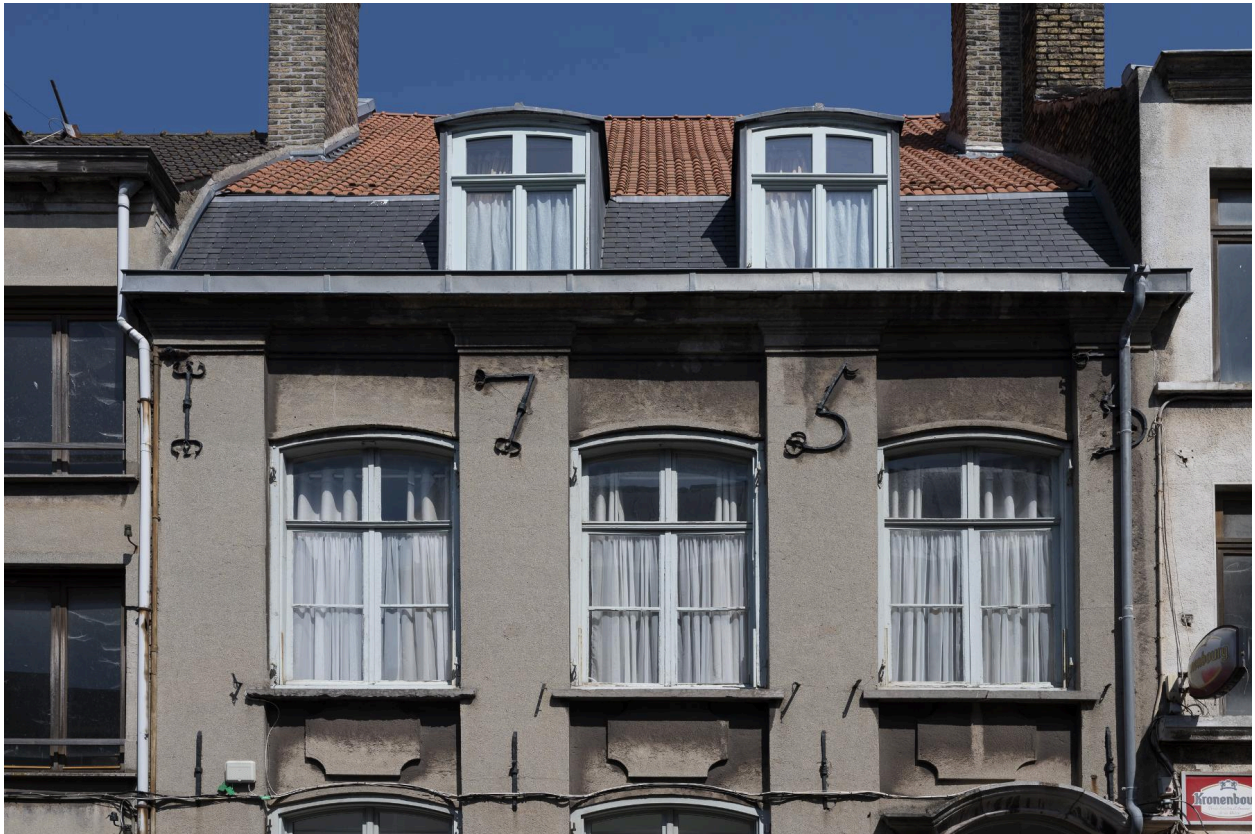
Vue de la date 1755 sur les fers d'ancrage.
