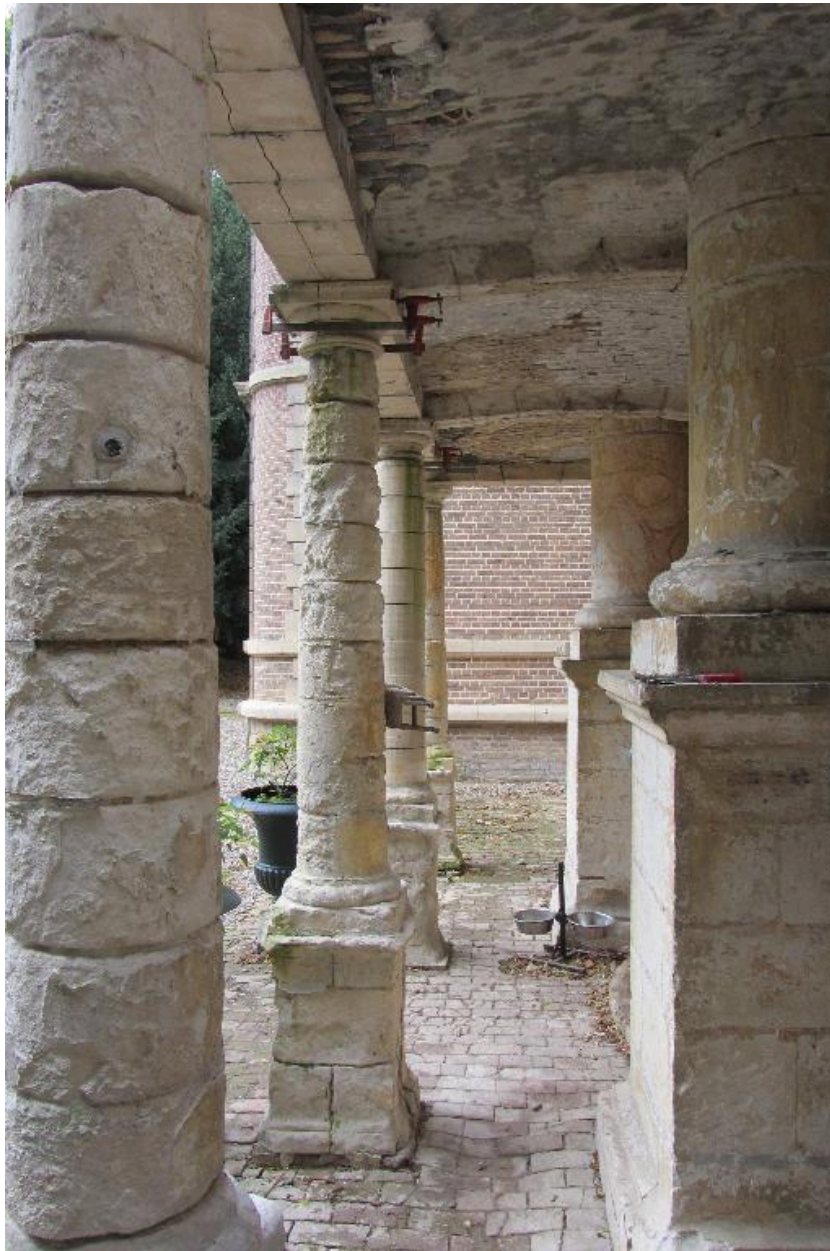
Détail des colones soutenant le balcon.
