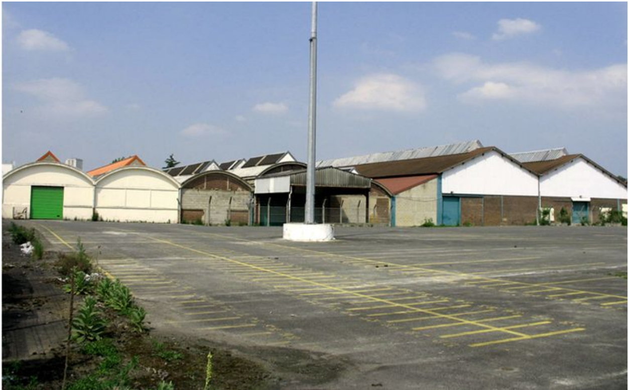
Vue générale des ateliers de fabrication.
