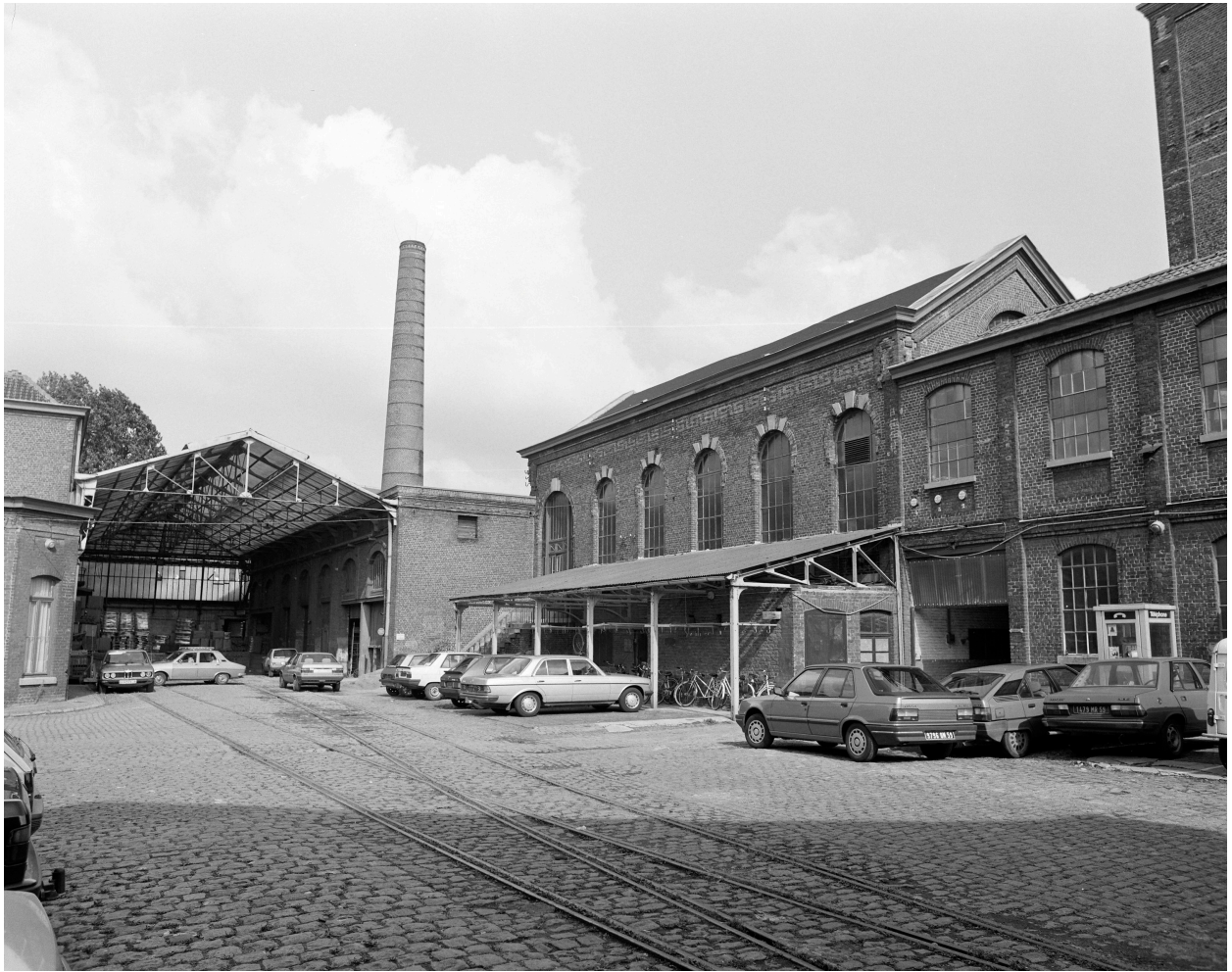
Vue générale de la cour. Vue prise vers le nord-ouest.
