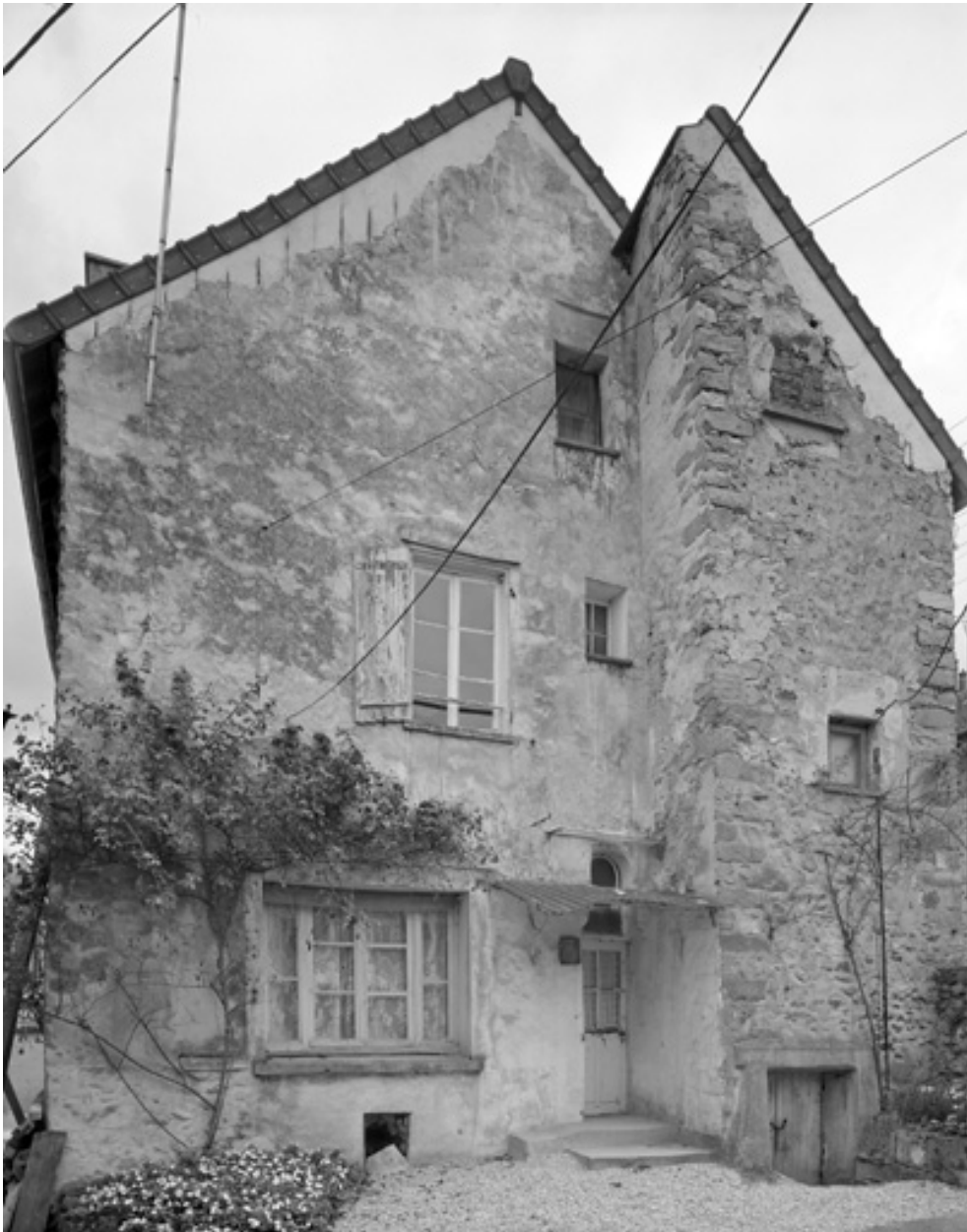
Vue de la façade avec l'escalier demi hors oeuvre.
