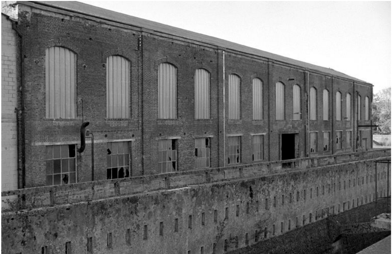
Atelier de fabrication, élévation antérieure.
