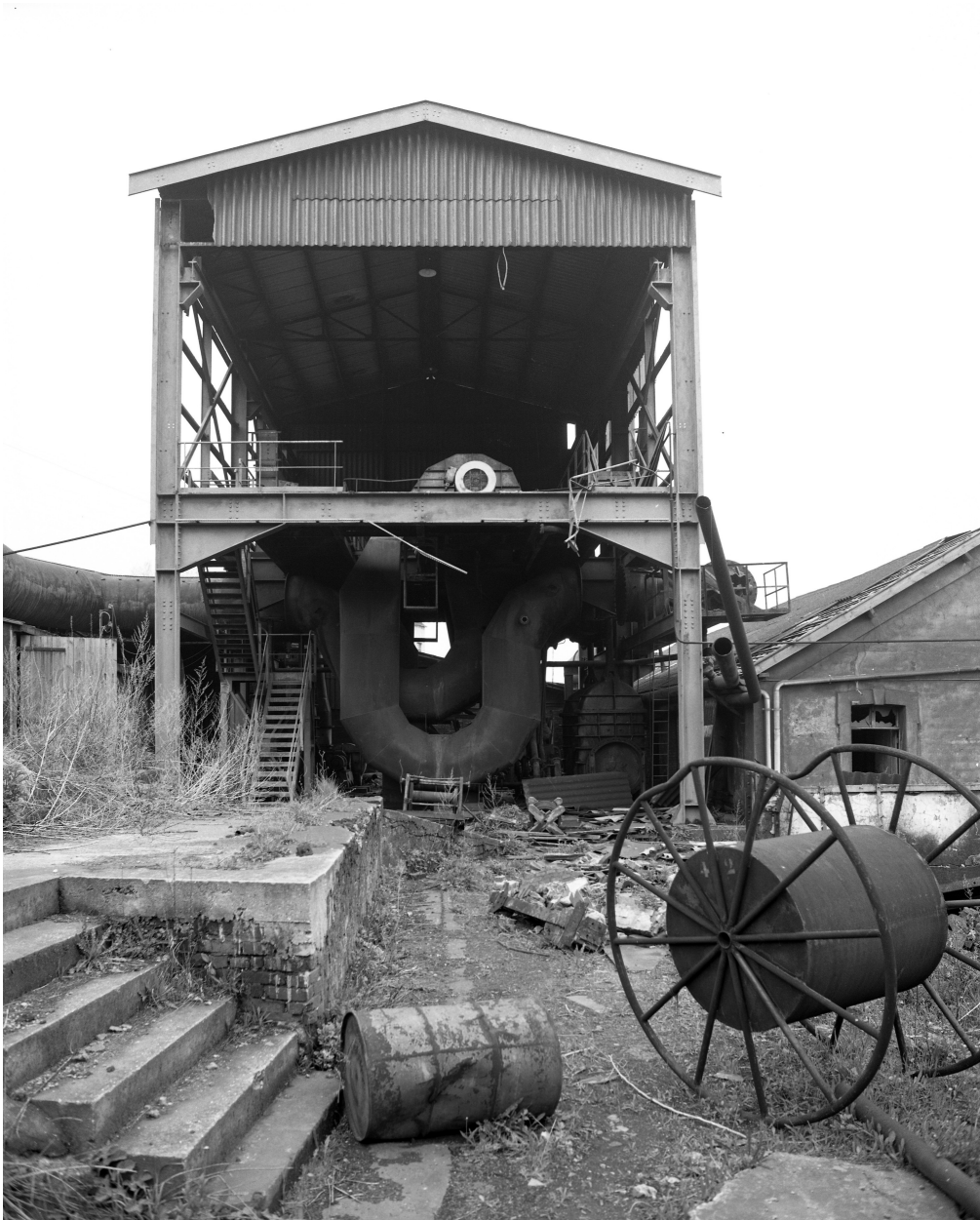
Station de surpression : pignon.
