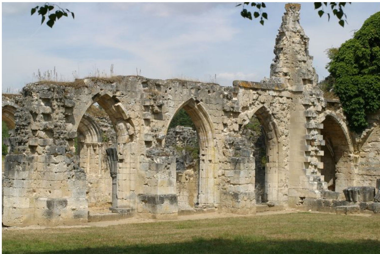
Vue partielle de la salle du chapitre.
