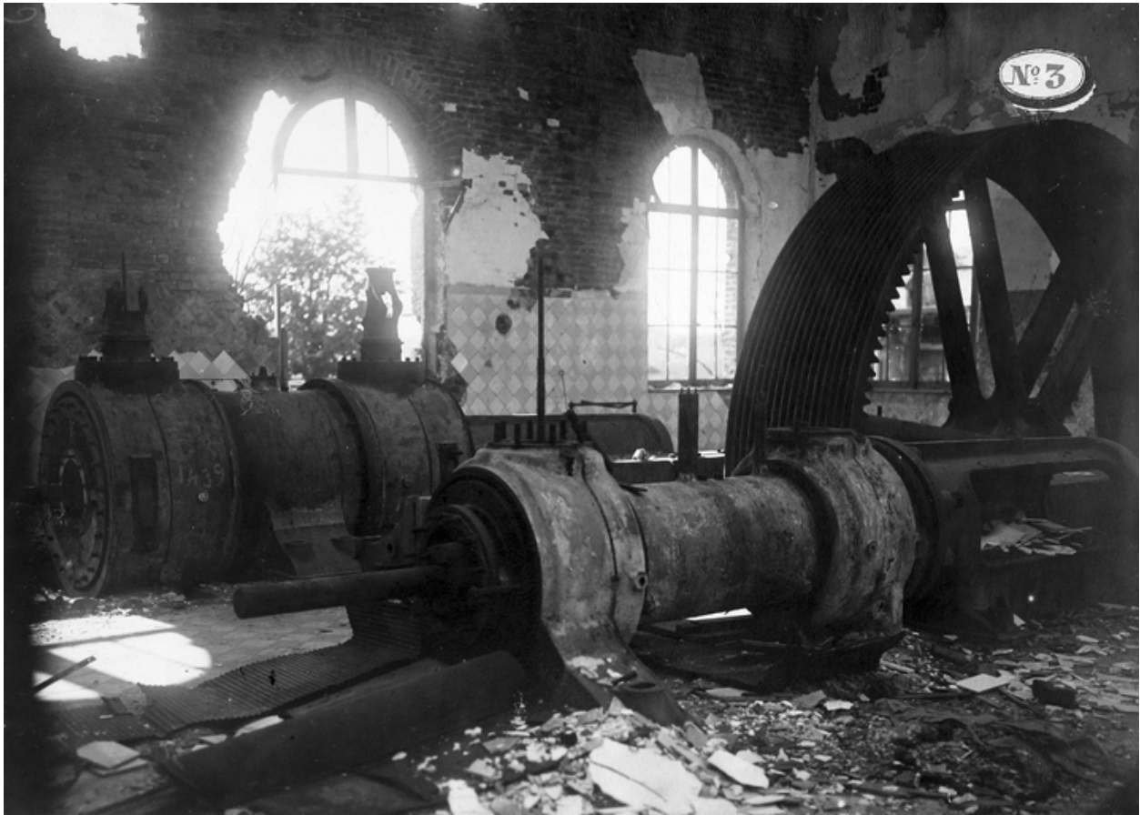
Salle des machines, vers 1919 (AD Aisne).
