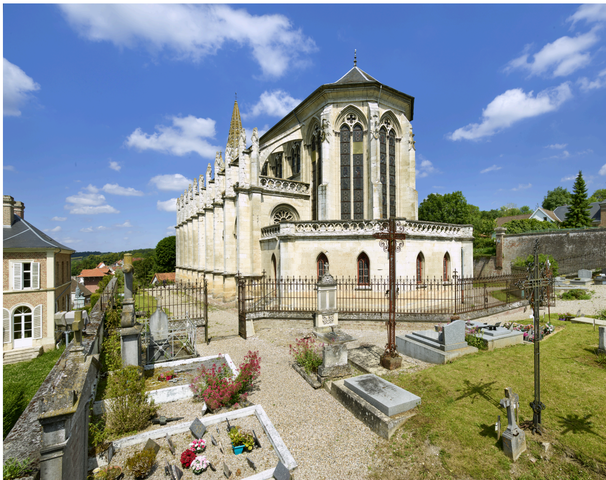
Vue sud-est de l'église, depuis le cimetière.
