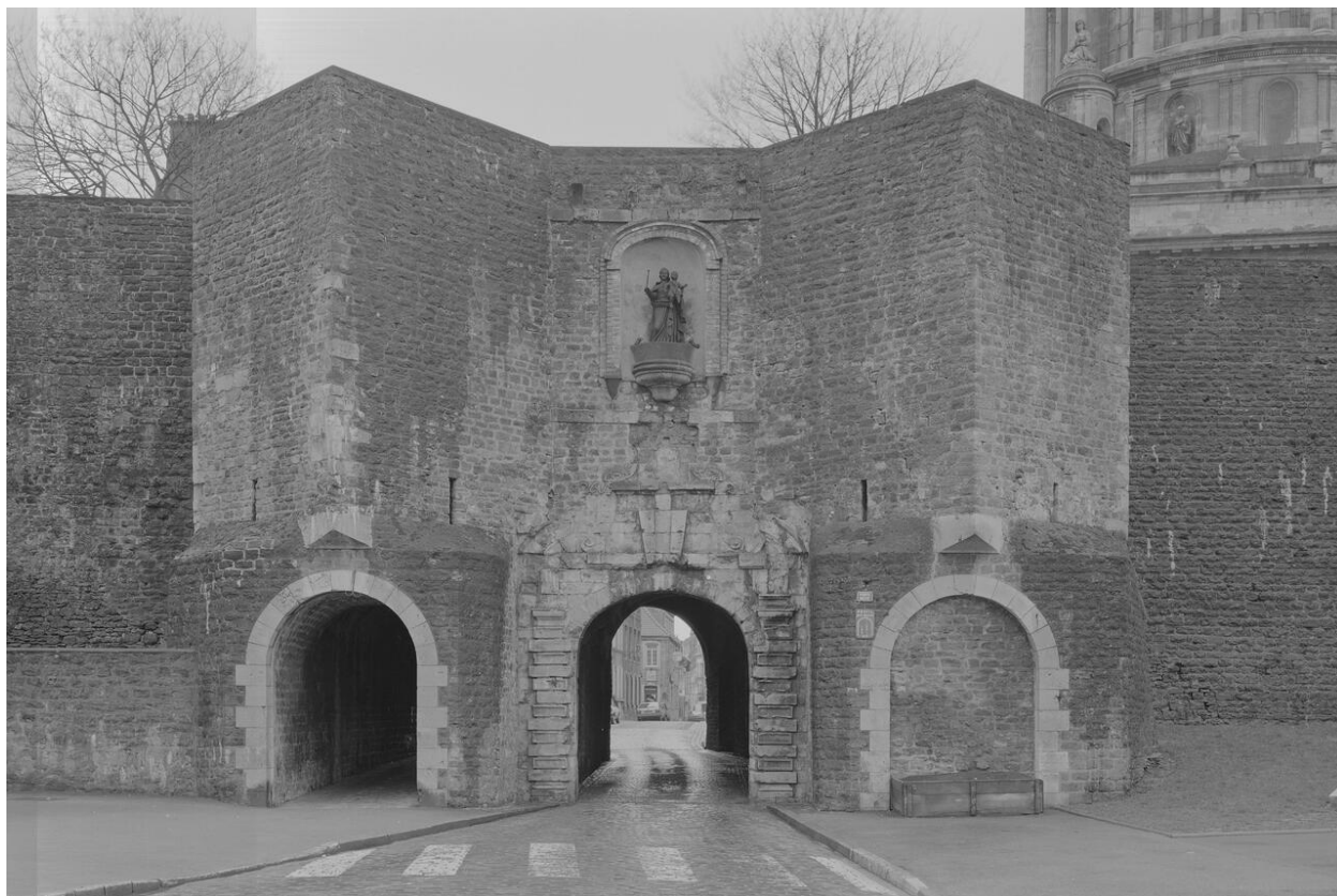
Façade sur boulevard.
