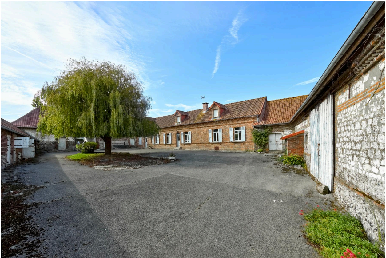
Ferme Trouart (24, rue Joseph-Harent). Grange et maison d'habitation en brique.
