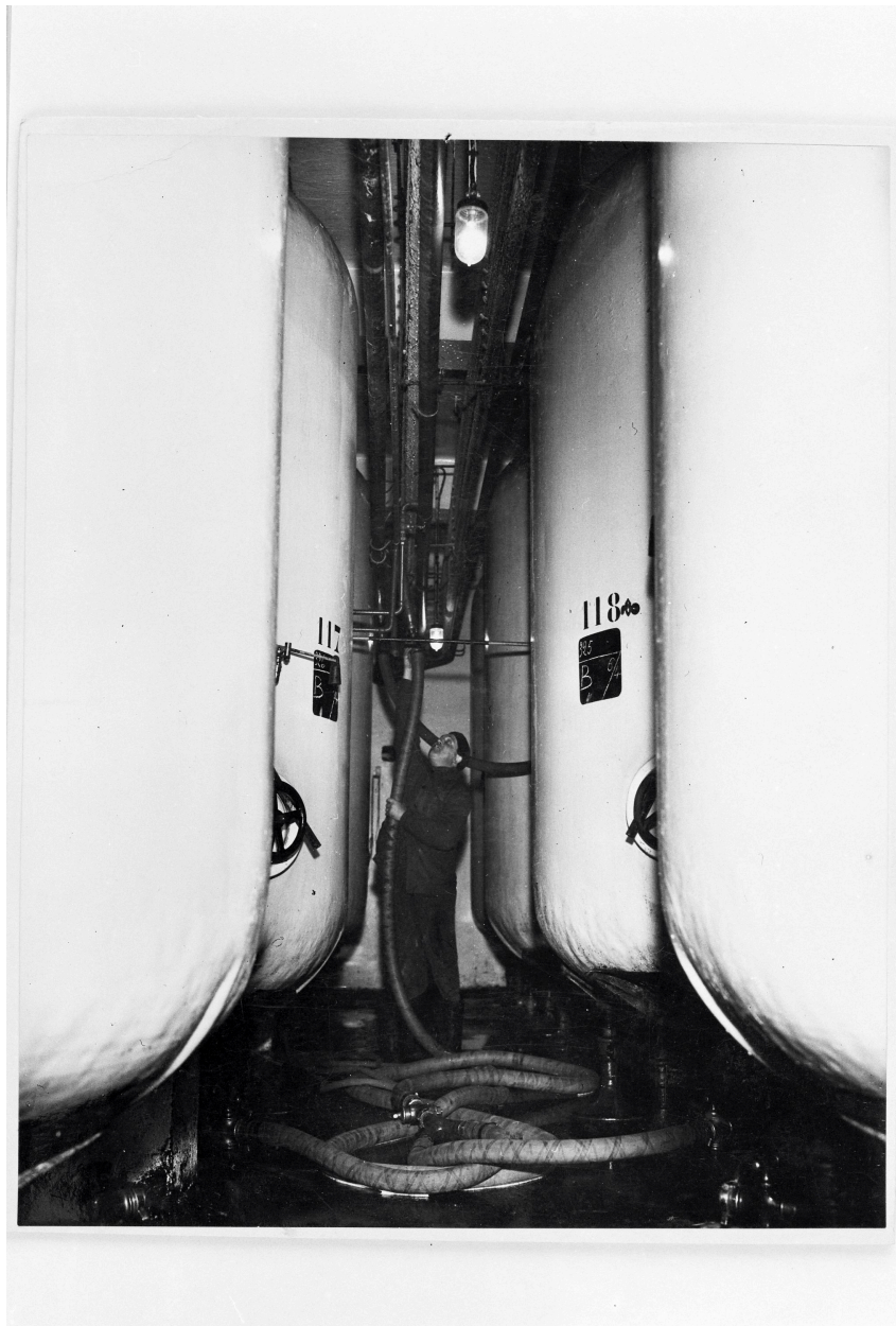
Salle de garde, tanks verticaux (AP Coutances).
