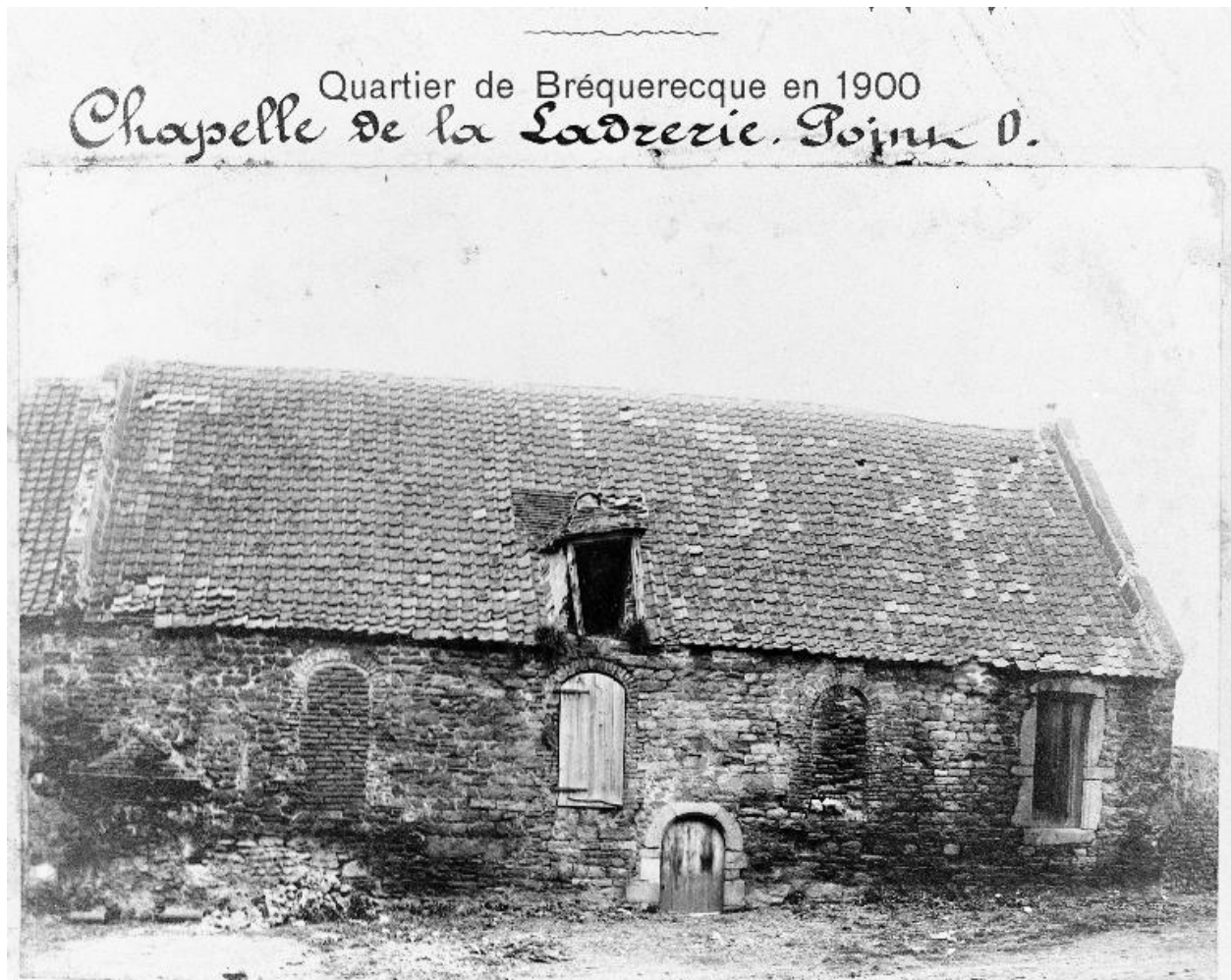
Chapelle, façade sur cour, état en 1900 (AC Boulogne-sur-Mer).
