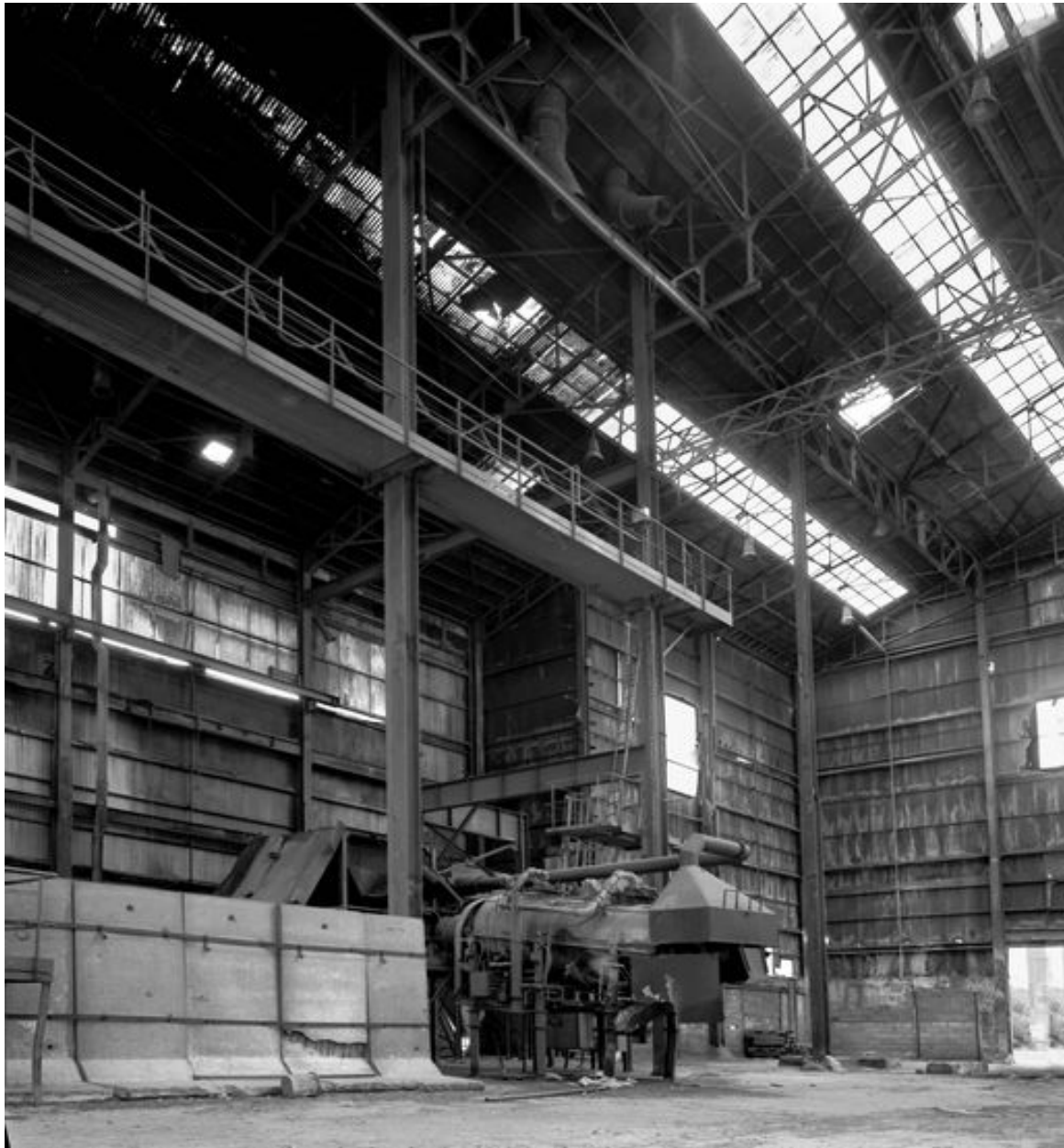
Intérieur du bâtiment abritant les fours.
