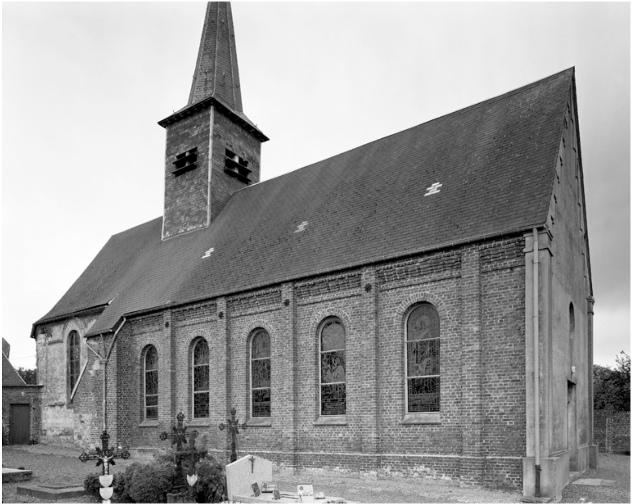
L'église vue du nord-ouest.
