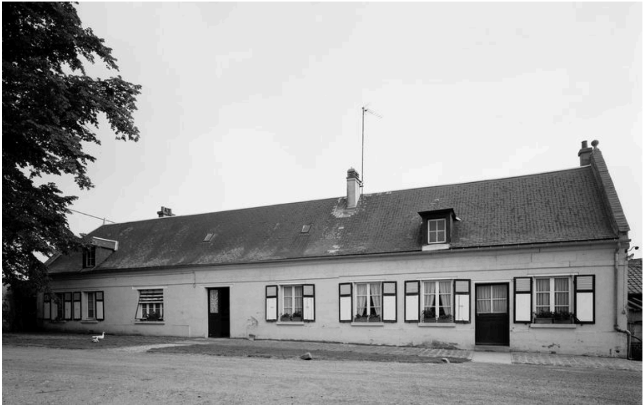
Logis. Élévation antérieure.
