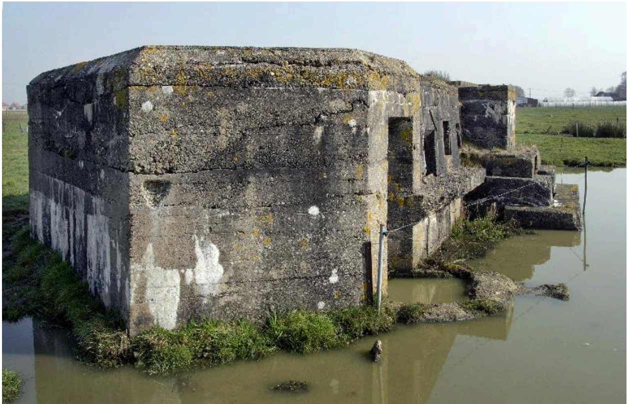
vue de trois-quarts vers le nord-est
