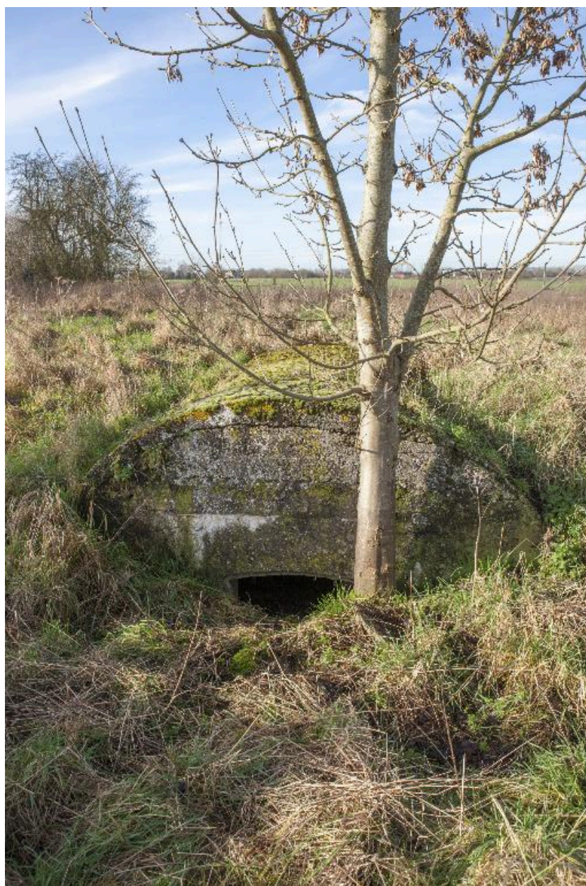
Un des abris, vers l'ouest
