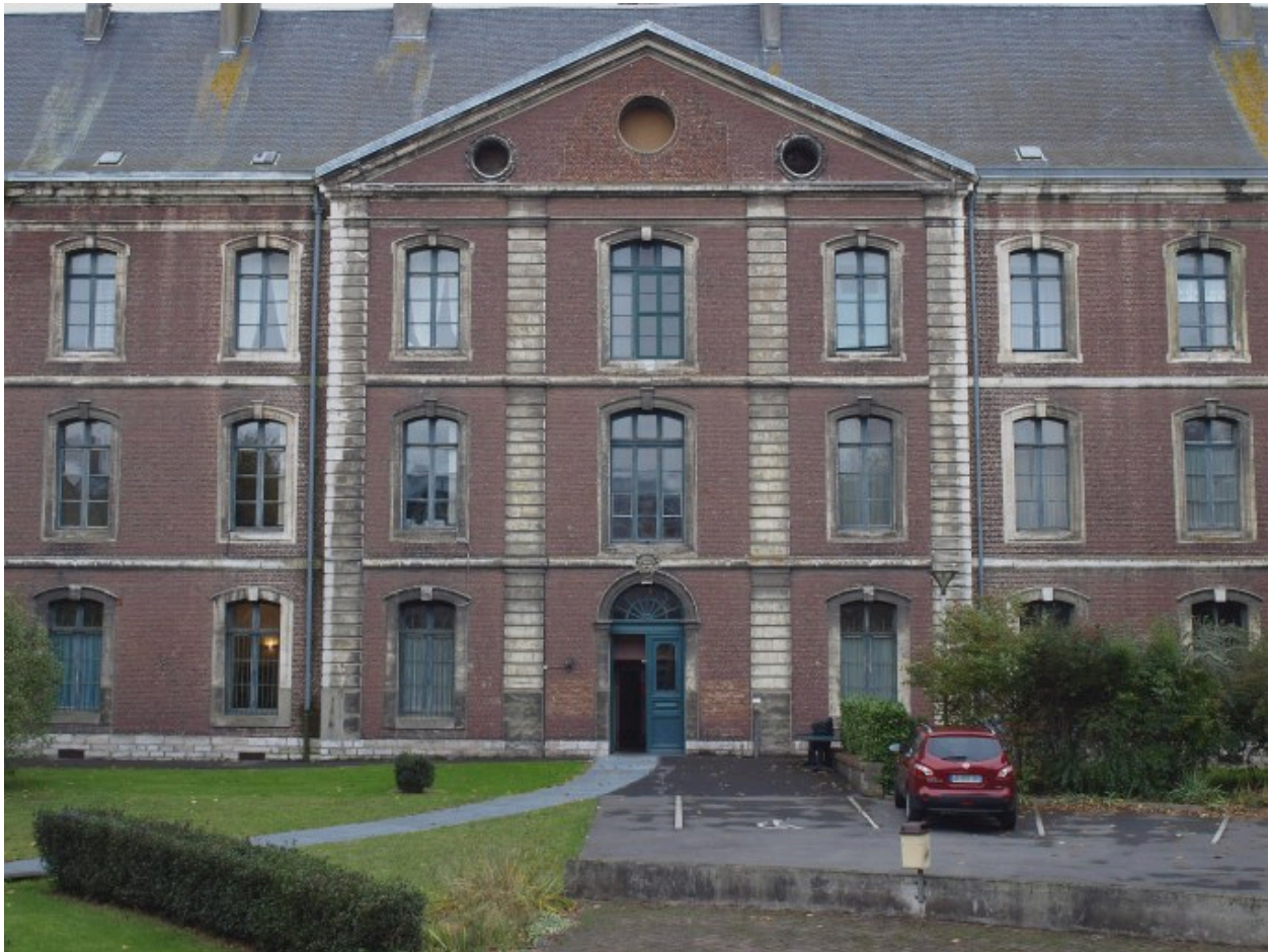
Pavillon central du bâtiment ouest
