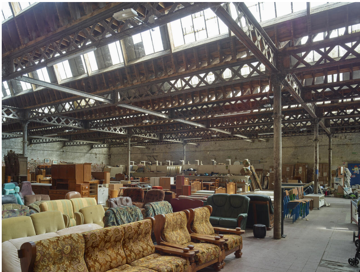
Vue intérieure de l'ancienne filature avec sa charpente métallique apparente.
